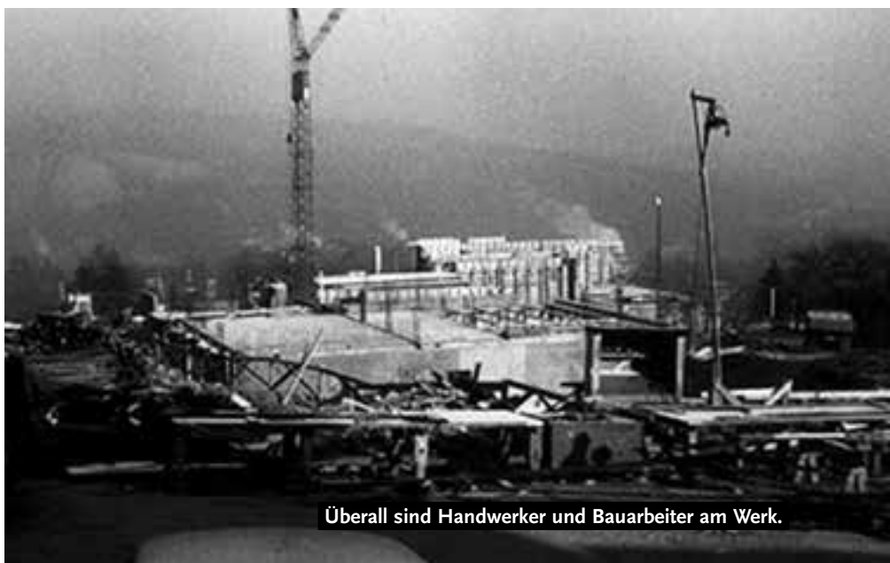
Auf der Baustelle im November 1968
